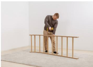
Girare le barre a muro e avvitare i quattro pioli anche sull'altro pezzo del telaio.
